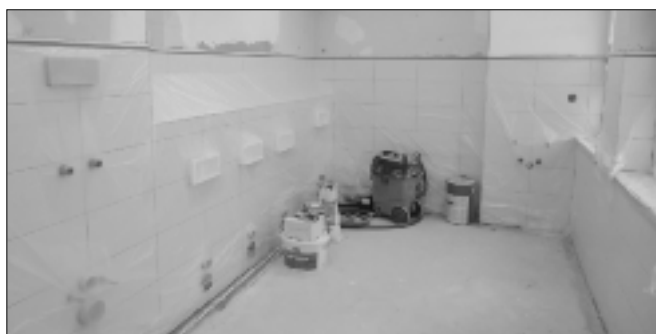
Umbauarbeiten in der ehem. Gemeindebücherei Oberlichtenau zur Erweiterung der Krippenkapazitäten am 03.12.2012, Foto: Martin Lohse
