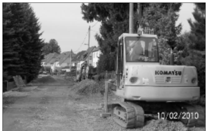
Grundhafter Ausbau der Merzdorfer Straße im Oktober 2010, OT Niederlichtenau, Foto Dr. Michael Pollok
