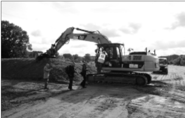
Erster Spatenstich zum Dammbau in Frankenberg/Sa. durch Umweltminister Frank Kupfer am 08.10.2012, Foto: Martin Lohse
