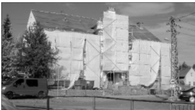
Energetische Fassadensanierung Grundschule Niederlichtenau Oktober 2009, Foto: Dr. Michael Pollok
