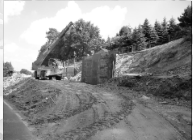
Verlegung der S 200 OT Ottendorf, Bereich der bestehenden S 200
